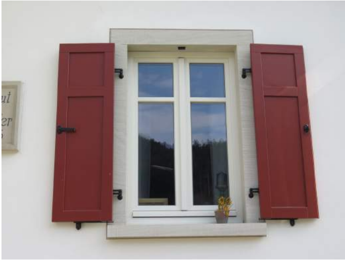
Neue Fensterläden in der Angerstraße 4 in Wallenfels
