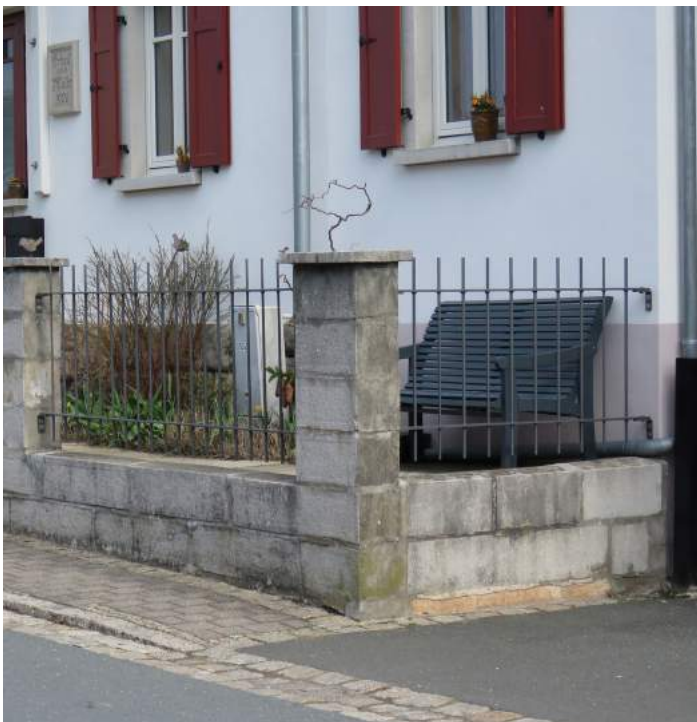
Einfriedung Kombination Metall und Stein in der Angerstraße in Wallenfels
