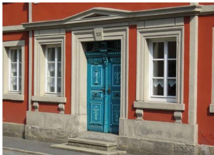
Sanierte historische Haustüre in der Hauptstraße in Wallenfels
