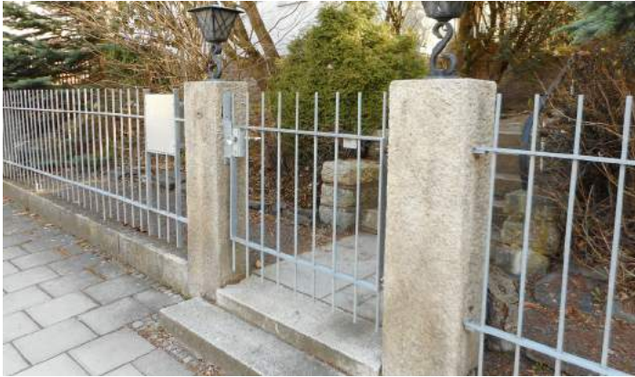
Schlichter Metallzaun und Betonsockel
