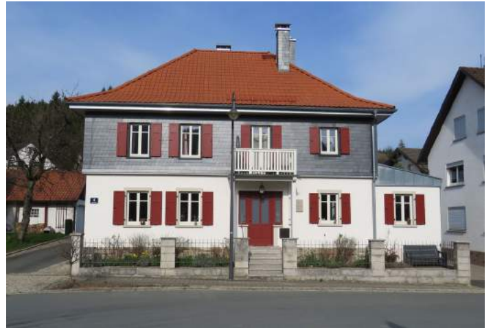
Angerstraße 4 nach Sanierung
