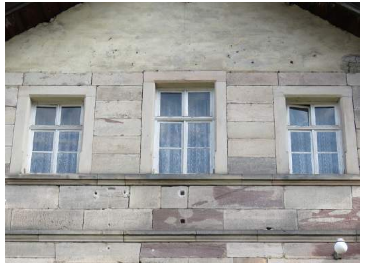
Historische Holzfenster mit 6-er Teilung in der Rathausgasse in Wallenfels
