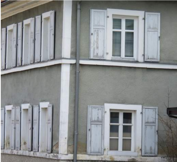
Historische Fensterläden in der Ailastraße in Wallenfels
