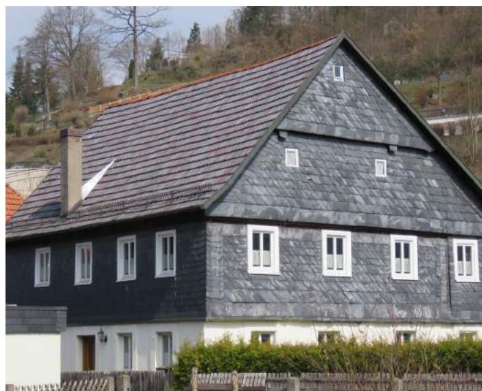
Historisches Wohnhaus in schlichter Form mit rechteckigem Grundriss und Satteldach im Mühlgraben in Wallenfels
