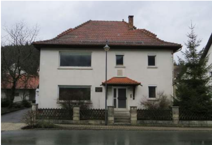
Angerstraße 4 vor Fassadensanierung
