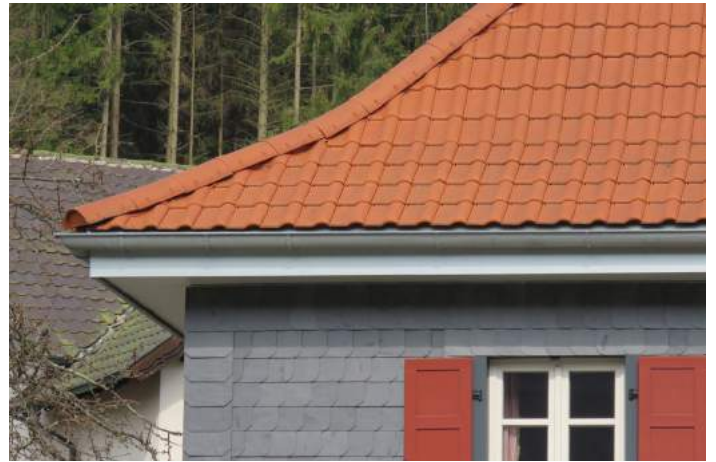
Sanierungsbeispiel in der Angerstraße in Wallenfels
