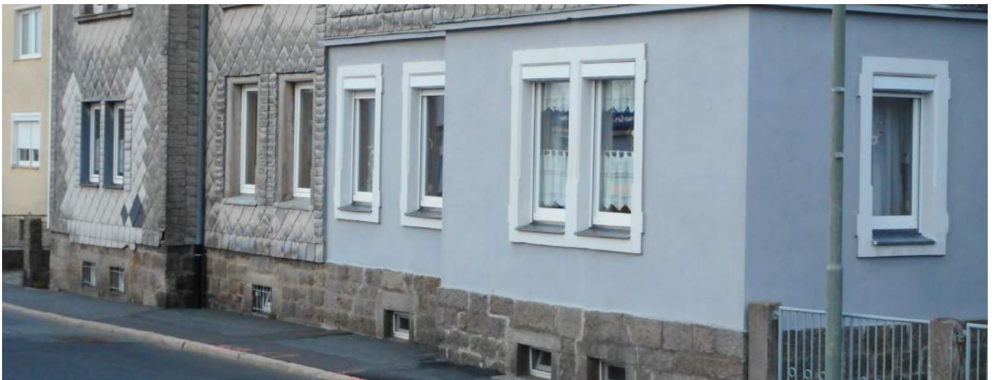
Beispiel Teilrückbau Kunstschieferverkleidung
