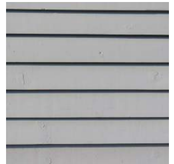
Stülpchalung, grau lasiert
