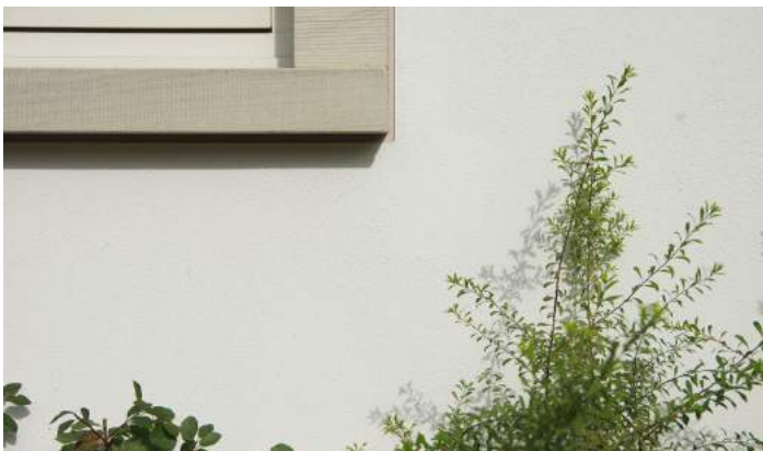
Putzfassade mit Sandstein
