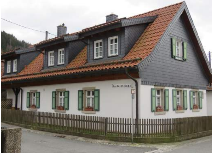
Einfriedung um Wohnhaus in der Frankenwaldstraße in Steinwiesen
