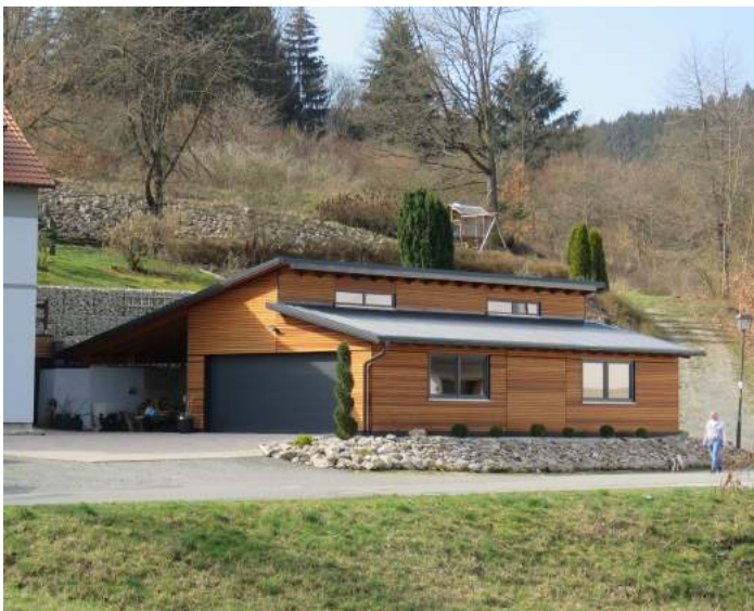
Neu errichtetes Nebengebäude in untergeordneter Größe Am Allerswald in Wallenfels
